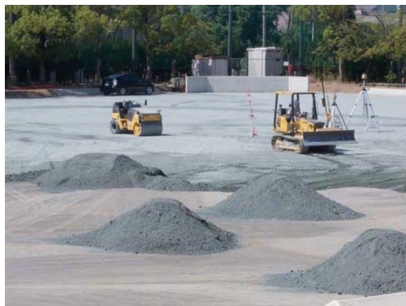
猛暑日の中行われた改修工事です
